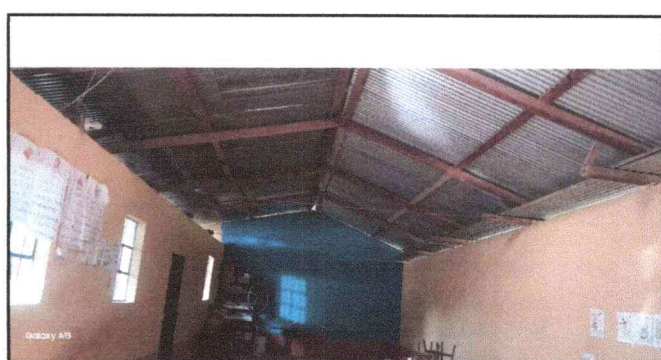
Foto 6: sustitucion de estructuras de madera por metal modulo 3
