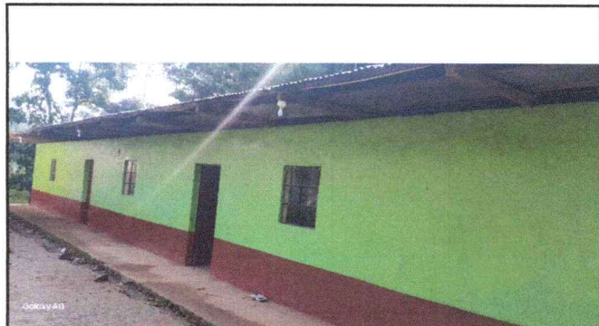
Foto 4: Sustitucion de estructuras de madera por metal del modulo 2
