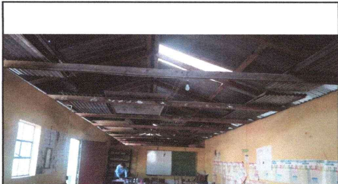
Foto 3: Sustitucion de capotes y estructuras de soporte de madera por metal
